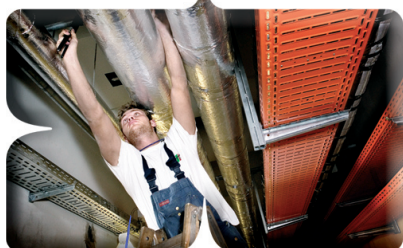
Industri- og procesventilation
